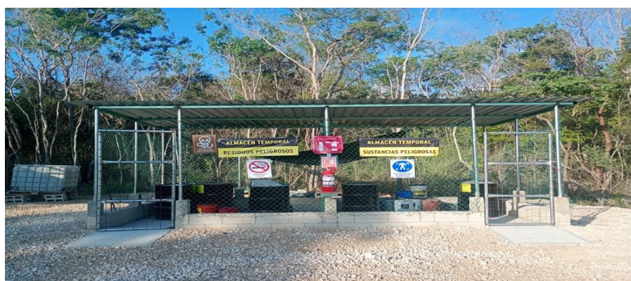
Figura 6. Instalación acondicionada como almacén temporal de RP.
