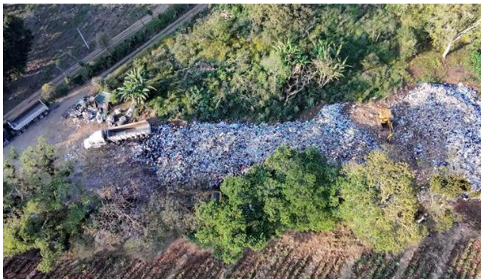
Figura 4. Vista aérea de las condiciones operativas del CTr de Coatepec, Ver.
