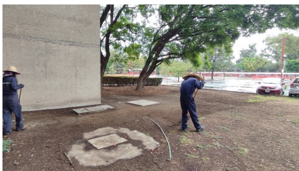
Figura 1. Suelo erosionado en la UAM-A.
