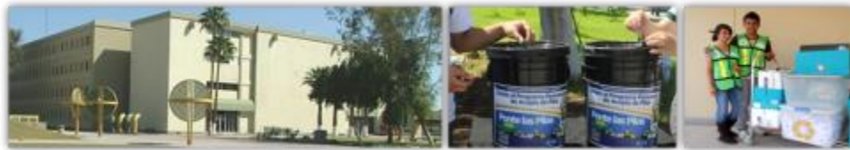
Figura 1. Edificio central de la FIM. Ejemplos de puntos acopio pilas y papel.
