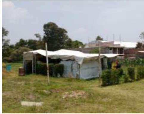
Figura 6. Almacén temporal de residuos de la UTP
