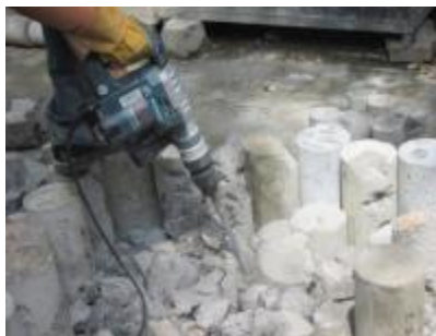
Figura 2. Pre-trituración de residuos de concreto
